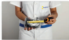
Controllare le dimensioni degli elementi da saldare.
