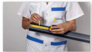
Marcare l'area da raschiare.
