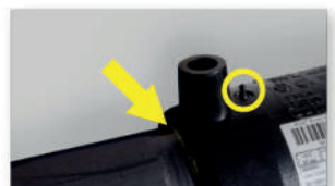
Avviare la saldatura. Effettuare i controlli previsti (allineamento, profondità di inserimento e indicatori di fusione).
