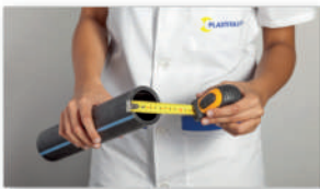
Controllare le dimensioni degli elementi da saldare.
